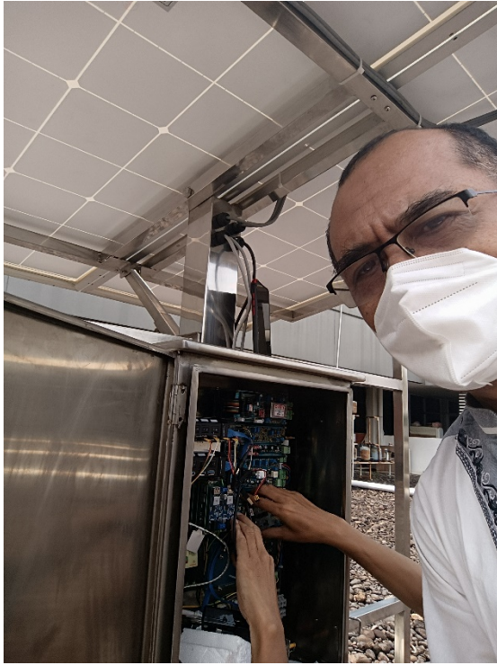
Pemeriksaan hasil instalasi sebelum sistem diuji
