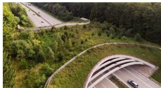
Jembatan yang disediakan bagi satwa diatas jalan raya.
