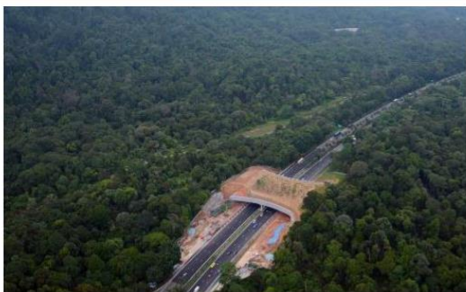
Jembatan yang disediakan bagi satwa diatas jalan raya.
