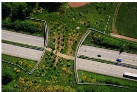
Jembatan yang disediakan bagi satwa diatas jalan raya.
