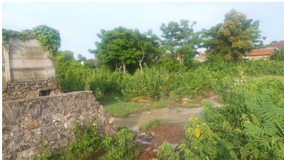
Gbr 7 .Foto Sungai didaerah perumahan Serang City Residen
